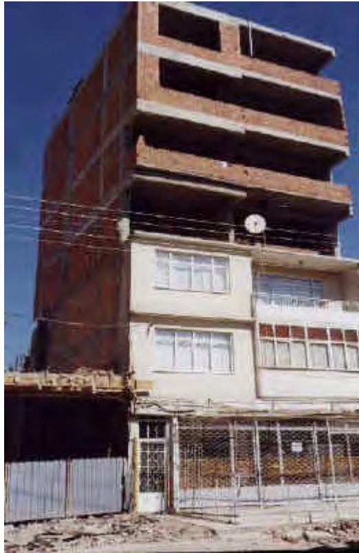
Foto 5.13. Edificio informal de siete pisos que originalmente fue de tres.
