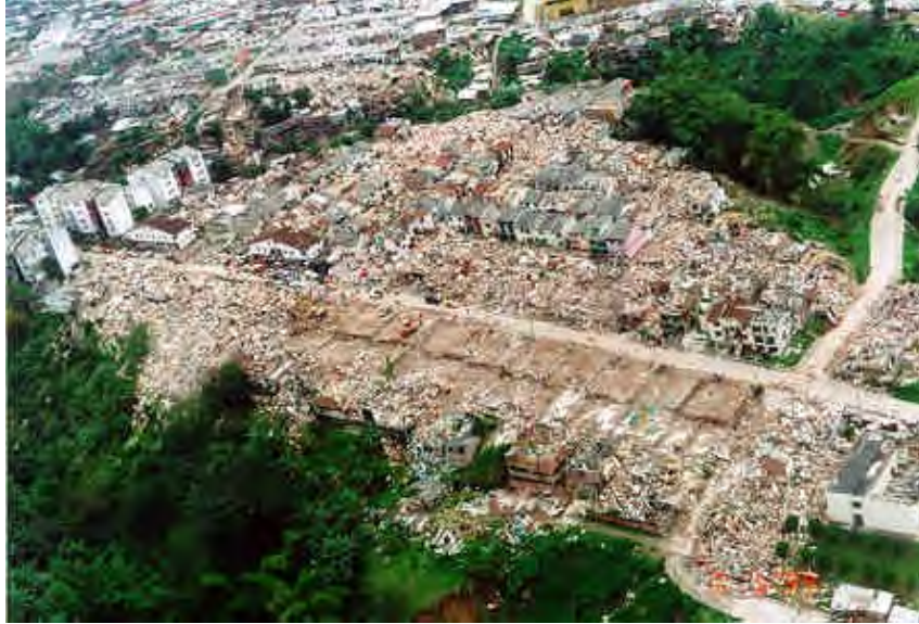
Foto 5.1: Armenia, capital del Quindío en Colombia después del sismo del 25 de enero de 1999, ilustra un escenario de riesgo sísmico materializado en desastre debido a la vulnerabilidad de sus edificios que no se construyeron con normas sísmicas.
