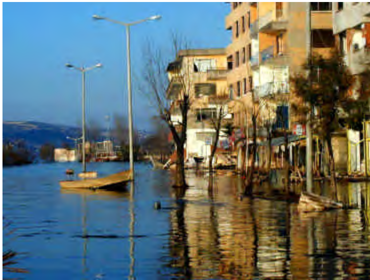
Foto 5.7: Debido a la hundimiento varios edificios quedaron sumergidos.
