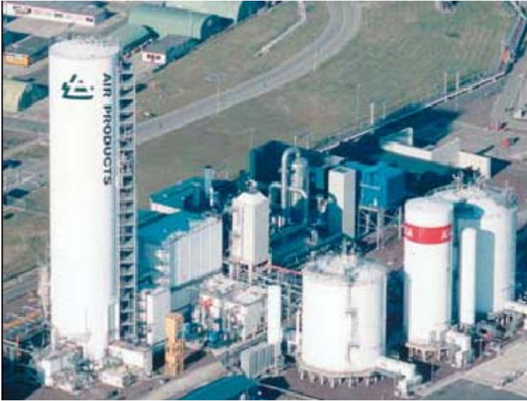
Şekil 3.9b 3000 ton/gün oksijen tesisi.
